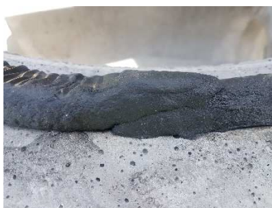
Etape 5 : Solidariser les parties de joint biseautées par légère pression.
