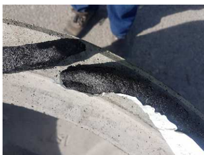
Etape 4 : Couper en biseau les 2 extrémités de joint.
