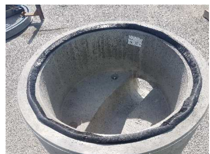
Etape 6 : Eliminer le film plastique de protection du joint et vérifier que le joint adhère bien aux parois béton de la portée de joint.
